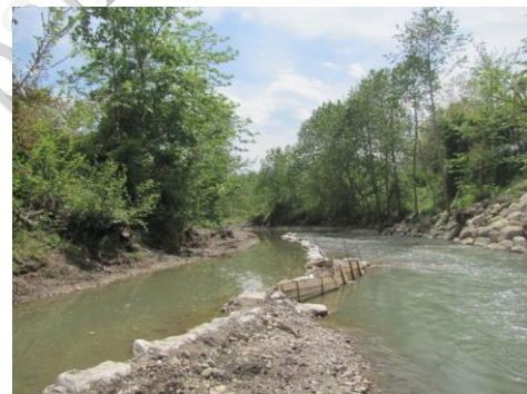
شکل ۳- محل شیل گذاری در رودخانه کاظم رود
